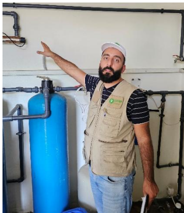
Installation d'un système de chloration pour une station de pompage d'eau solaire dans la communauté d'Haour Taala – Baalbek, située dans la vallée de la Bekaa.
